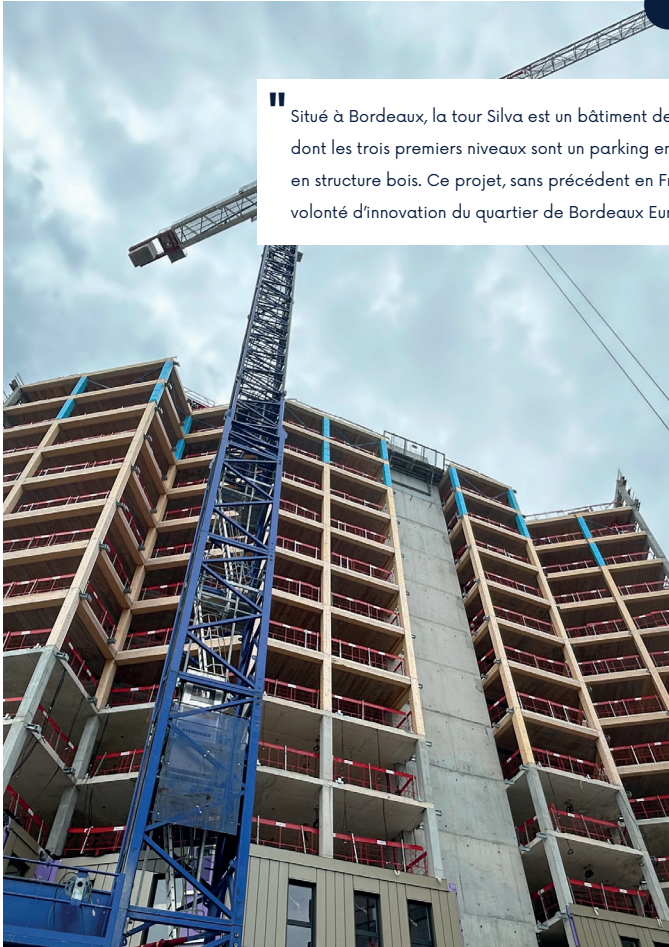
Construction de bois
